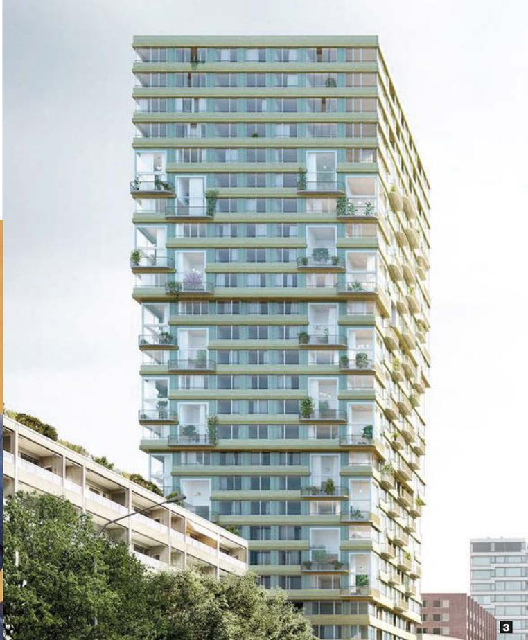
aux oscillations induites par le vent réduit le confort des occupants et peut causer des problèmes d'aptitude au service dus à la flexion. Pour cette raison, il est plus que temps de répondre à la question de la hauteur maximale pratique des bâtiments en bois de grande hauteur.
