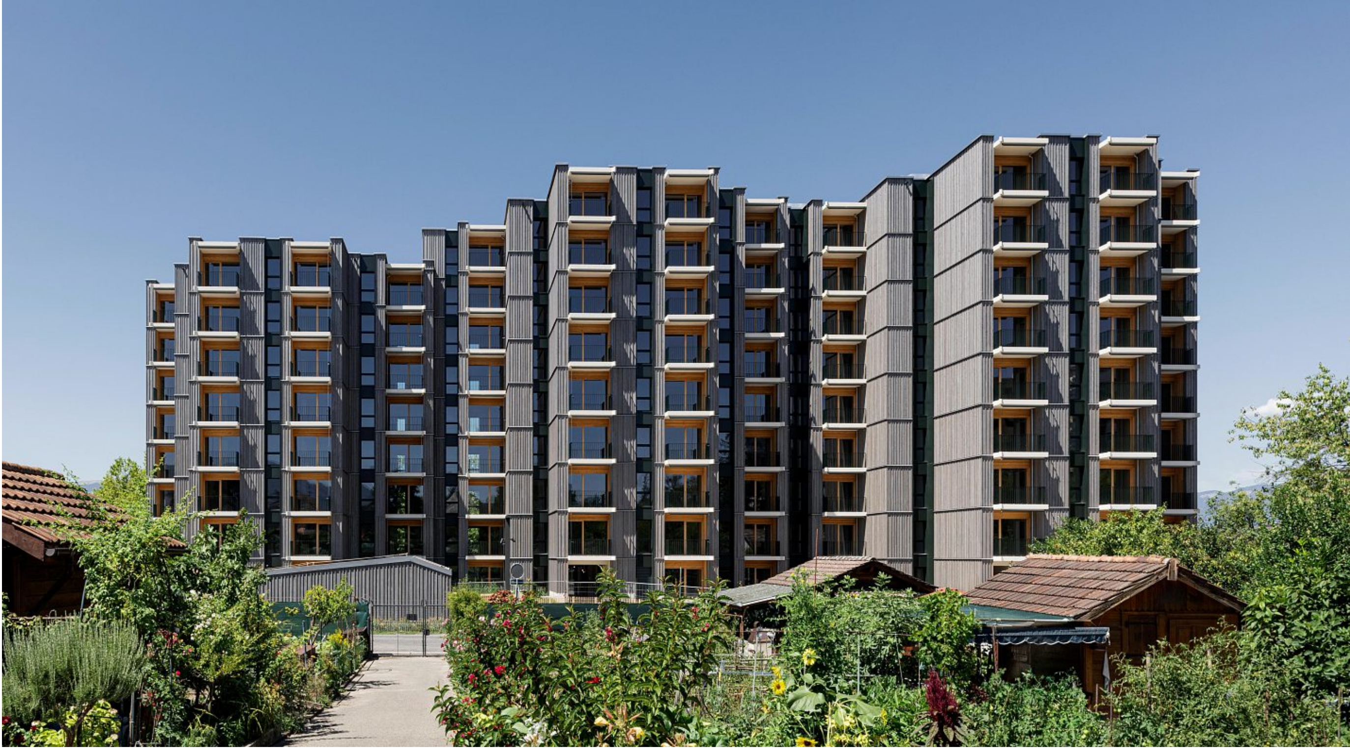
L'immeuble de logements d'utilité publique de neuf étages dans le quartier des Libellules. Il attend ses habitants.
