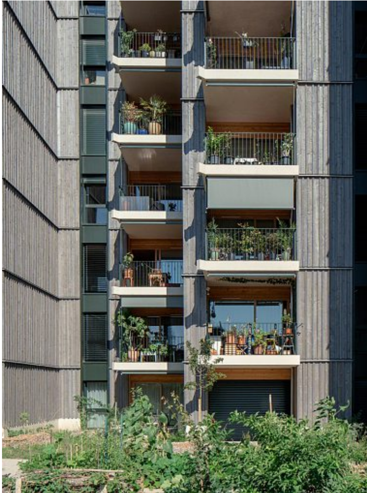
Les PPE de l'ensemble Actaris, déjà habitées depuis un an. Axel Launay
